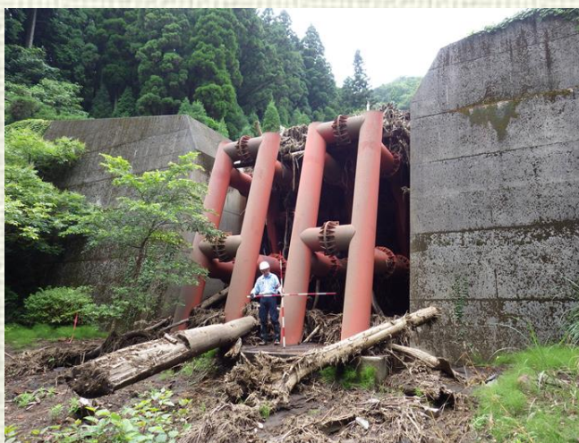
写真4 2016年熊本県阿蘇山で撮影した最近の砂防堰堤（鋼製スリット型）
